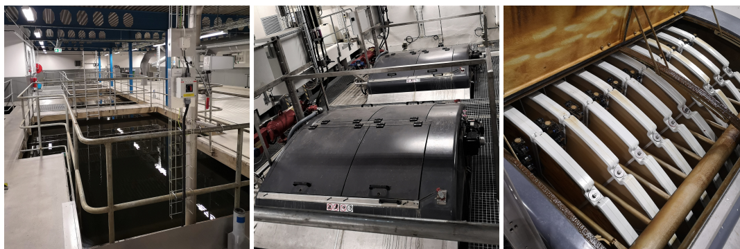
(a) Automatiskt reglerad ASP, första (b) De två skivfilterenheter, stäng- (c) Öppet skivfilter med 10 skivor delen i biosteget. da. och dysor på varje skiva.
