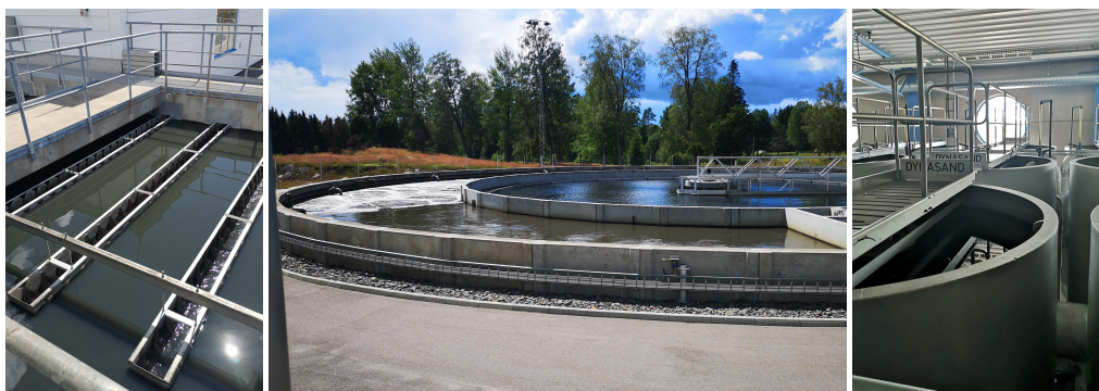
(a) En av försedimenta- (b) En av biobassängerna med biologisk kväve och fos- (c) Några av DynaSand- tionsbassängerna. forreduktion. filterenheter.
