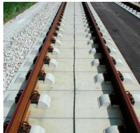
(b) Ballastfritt spår med prefabricerade betongplattor.
