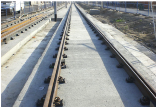
(a) Ballastfritt spår där slipers gjutits ned i betong.
