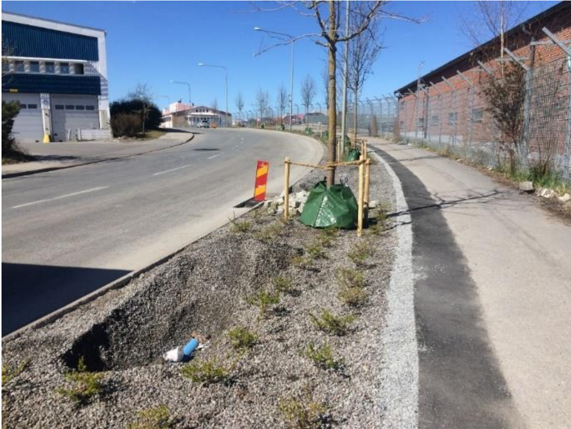
Figur 5. Dräneringsstråk längs med Gunnebogatan inom Lunda industriområde.
