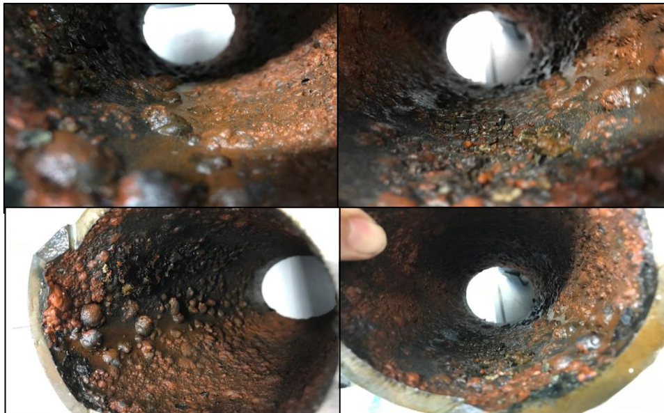
Figur 27: Fotografier av en bit av den ledning som togs bort från ledningssträcka A under våren 2021. Tydliga bubblor kan observeras till följd av korrosion på rörets insida.
