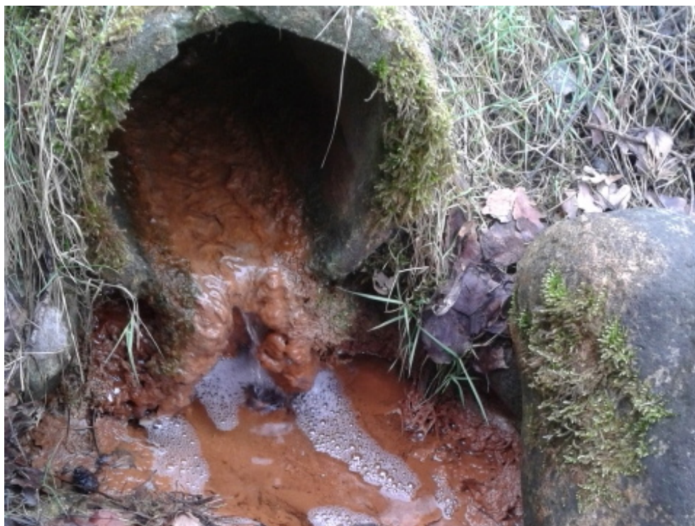
Figur 14. Inkommande lakvatten till Södergarnsdammarna (Damm 1). Foto: Carolina Gårdefors.
