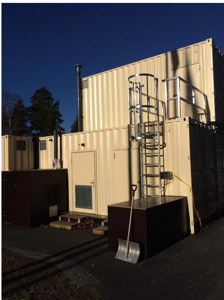
Figur 2. Pilotanläggningen vid Lovö vattenreningsverk sedd utifrån.
