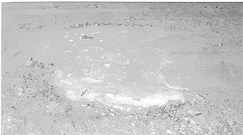
Bild 2. Tunnelvatten på botten av Åsatunneln.
