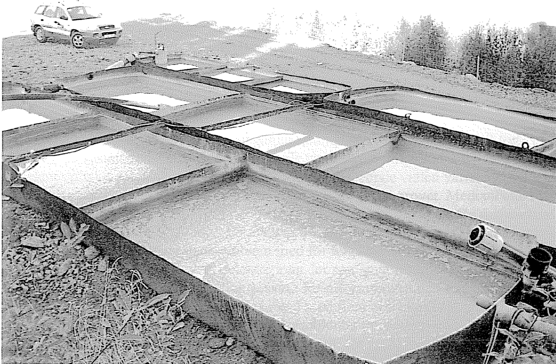
Bild 8. Seriekopplade cisterner som används som slamfälla vid Strannetunneln.
