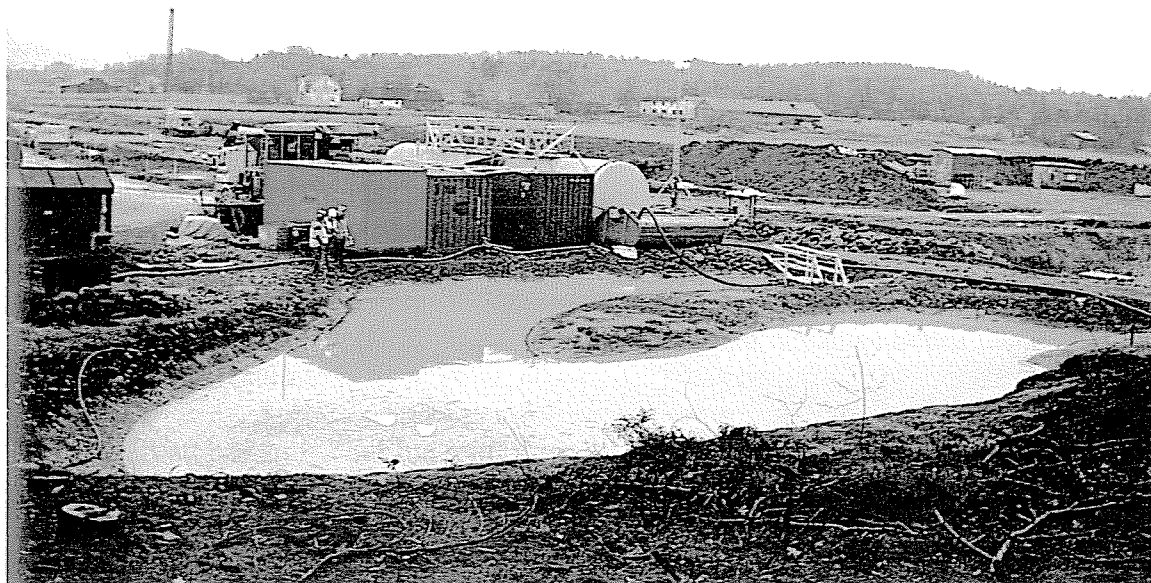
Bild 7. Grävd damm som används som slamfälla vid Åsatunneln.
