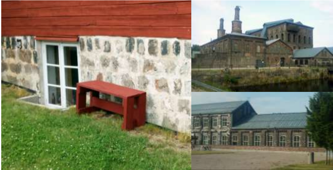
Figur 3. Slaggsten är en vanlig syn vid gamla byggnader i Bergslagen. Till vänster ett bostadshus i Avesta kommun med slaggsten i grunden. Till höger ses slaggstensbyggnader i det gamla bruksområdet i Avesta.
