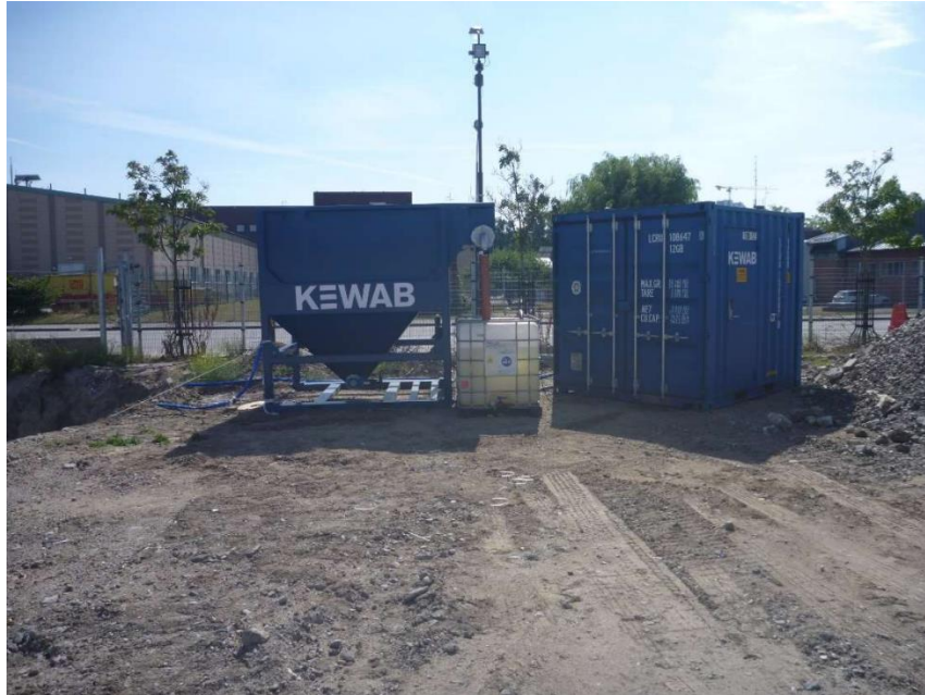
Figur 1. Mobilt reningsverk för rening av överskottsvatten. I det första steget (till vänster i bild) tas sediment bort, i det andra steget (till höger i bild) behandlas vattnet med kolfilter. Fotot är taget från relationshandling för kv Makrillen (Karlström 2021).
