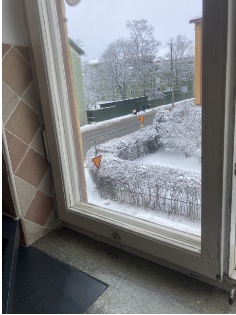
(a) Mätning B fönster.
