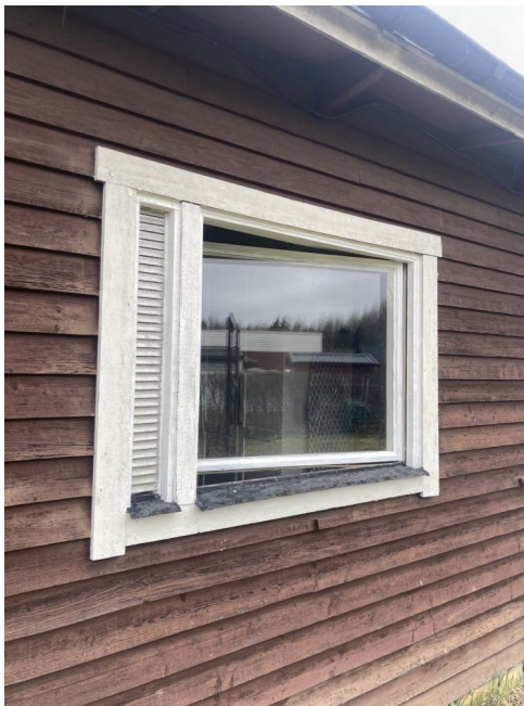
(a) Utvändig vädringslucka.
