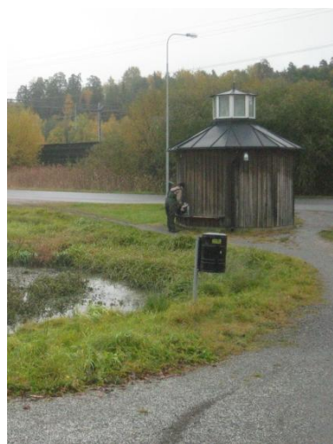
Figur 2. Pumpstationen vid Ladbrodammen. Foto: Annika Persson.
