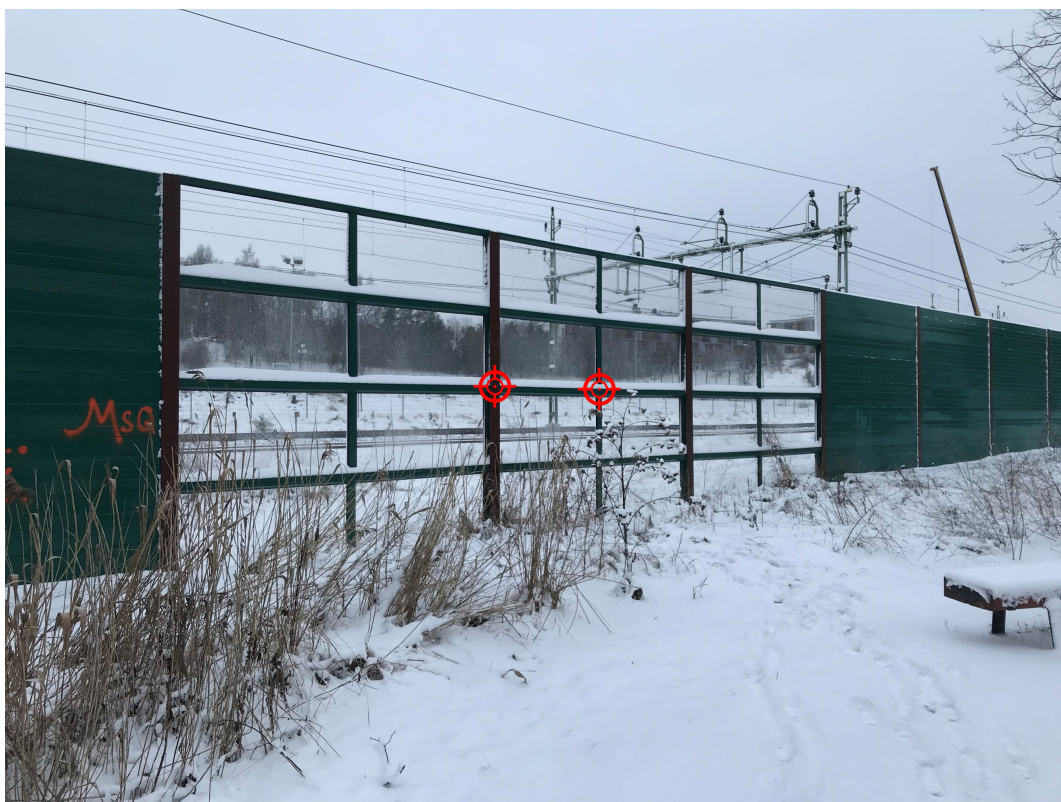
Figur 9. Bullerskyddsskärmen i Knivsta, absorberande skärmelement/kombinerat glas. De röda cirkelarna visar vart mätningarna utfördes.
