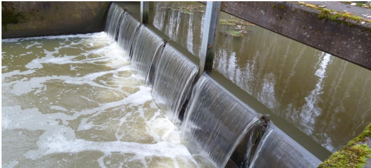
Figur 8. Bild på skibordet som fungerar som en bestämmande sektion där nivåmätningar har utförts.
